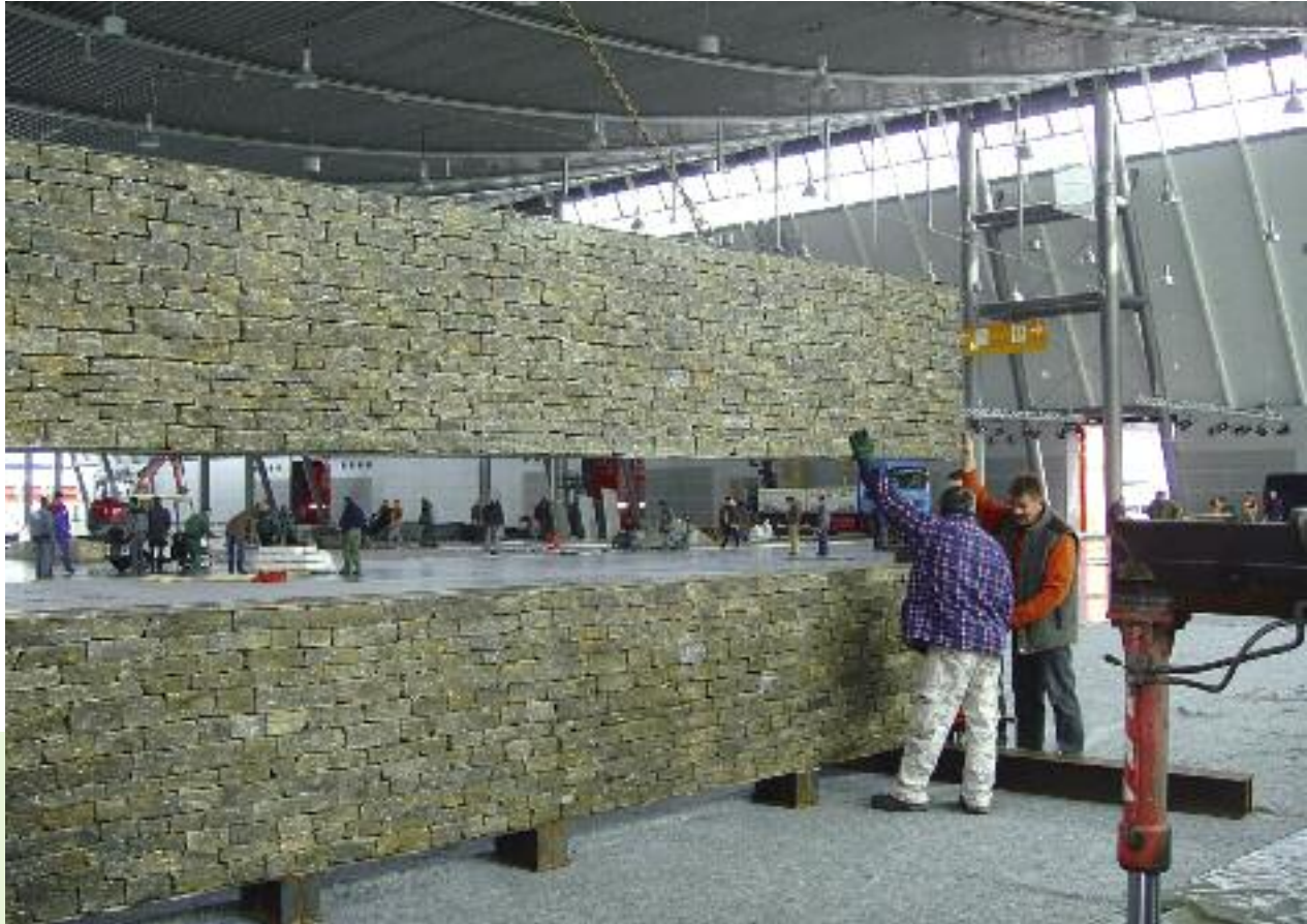
Das Stellen der Natursteinwand: noch ist der Hallenboden blank und leer. Foto: Utz
